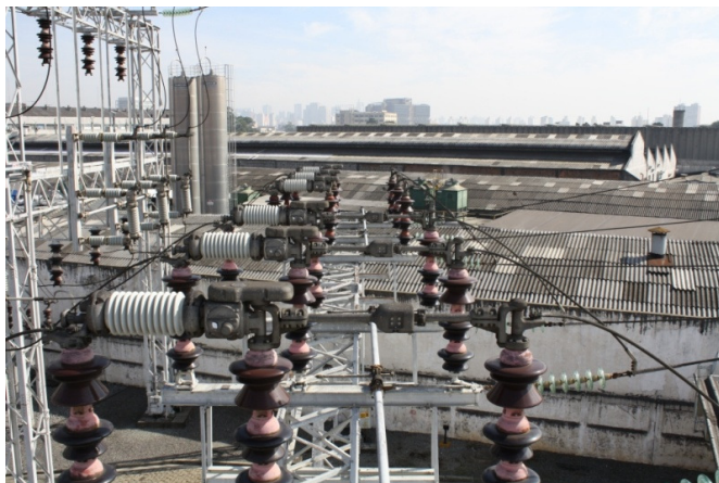
Fig. 1. Conjunto de chaves seccionadoras monitoradas pelo sistema.
